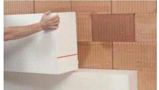
**Anwendung:** Fassadendämmung (Vollwärmeschutz) im Wärmedämmverbundsystem (WDVS)
