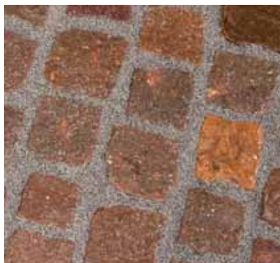
11. Het voegwerk 24 u. beschermen tegen belasting.
