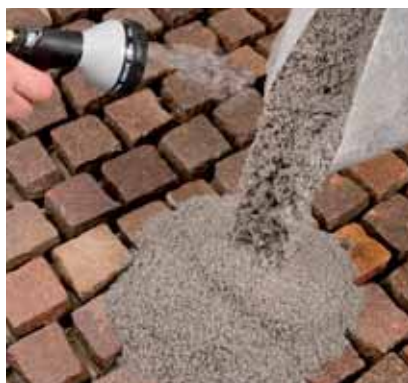
5. Het voegmateriaal op de stenen verspreiden en uitvoerig besproeien.
