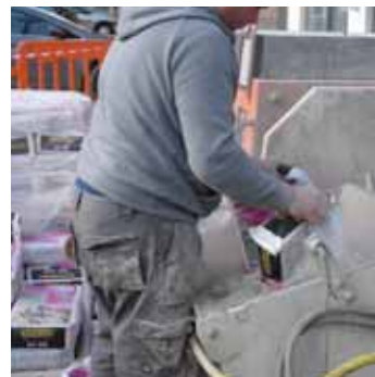
2. Met behulp van een menger of betonmolen, een homogene, klontervrije massa aanmaken.
