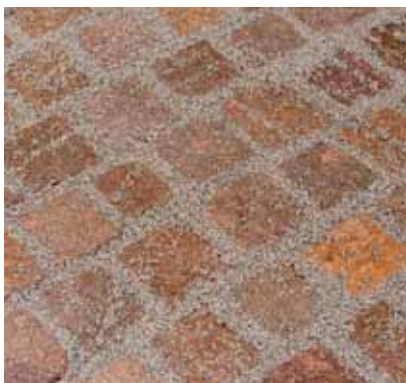
7. De voegen gelijkmatig en tot aan het oppervlak vullen.
