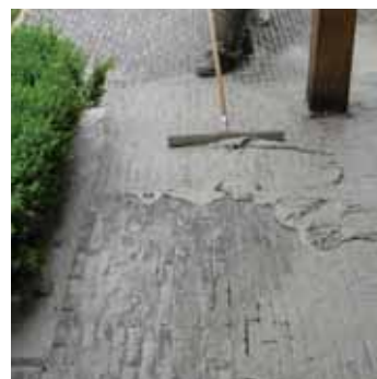
6. De aangemaakte voegmortel met een vloerwisser diagonaal op de voegrichting in de voeg brengen.
