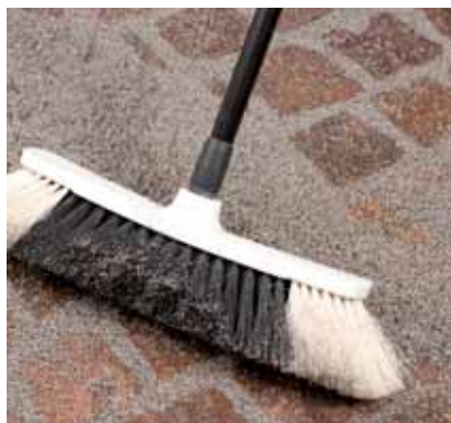
8. Overtollig materiaal voorzichtig met zachte bezem verwijderen.
