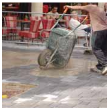
5. De voegmortel over het oppervlak verdelen.
