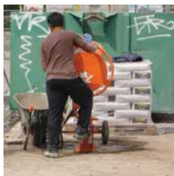
3. Mengverhouding: ± 4,75 L water + 25 kg SF 50. Mengtijd: ± 3 min.
