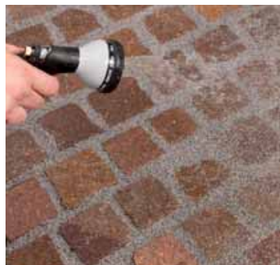
9. Licht beregenen zorgt voor een hogere verdichting van de voeg ; de waterstraal niet rechtstreeks op de voegen richten.
