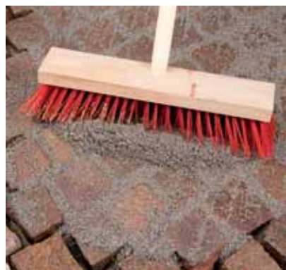
6. Met een straatborstel diep, vast en verdichtend verdelen in de voegen.
