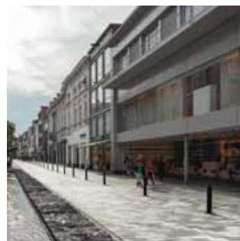
8. Het voegwerk beschermen tot uitharding ; begaanbaar na ± 8 u., volledig belastbaar na ± 24 u. (i.f.v. de weersomstandigheden)
