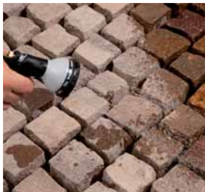
2. Het oppervlak sterk voorbevochtigen.
