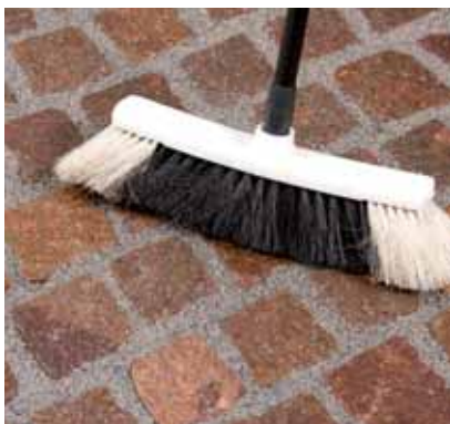
10. Met een zachte bezem de restanten diagonaal volledig inkeren.
