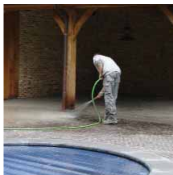
7. ± 10 - 30 min. na het inbrengen van de mortel het oppervlak reinigen met zuiver water. Het overtollige water wegnemen.
