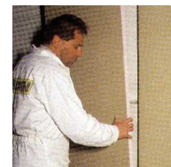
Richten van de plaat
