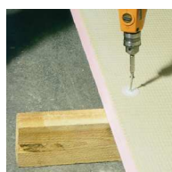
Vastschroeven op houten balken
