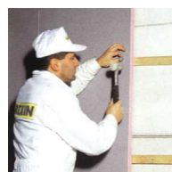
Vastschroeven op houten roosting
