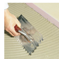
Als isolatieplaat op dekvloer
