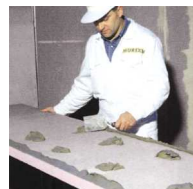
Lijmen van de plaat
