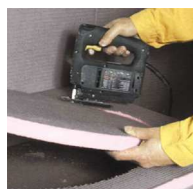
Op maat snijden met decoupeerzaag
