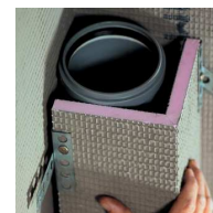
Bekleden van afvoerbuis
