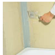
Plaatsen van afdichtingsband
